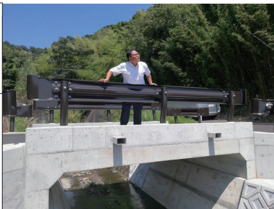
久能地区殿谷川無名橋の新設工事完了、通常時は農道として、津波避難時は高台にあり、中平松と青沢を結ぶ避難路として活用できます
