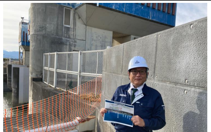
大谷放水路から東へ、L1防潮堤整備の現地視察
